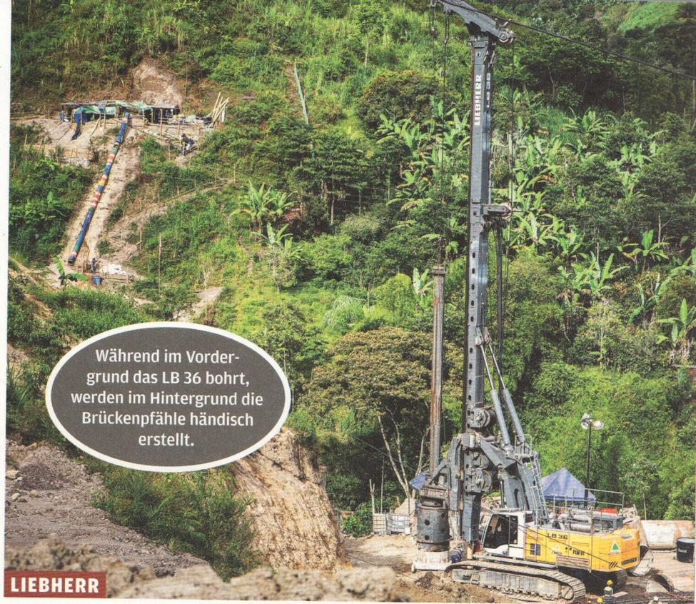
Während im Vordergrund das LB 36 bohrt, werden im Hintergrund die Brückenpfähle händisch erstellt.
